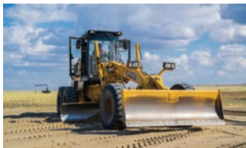
в) Разравнивание песчаного основания
