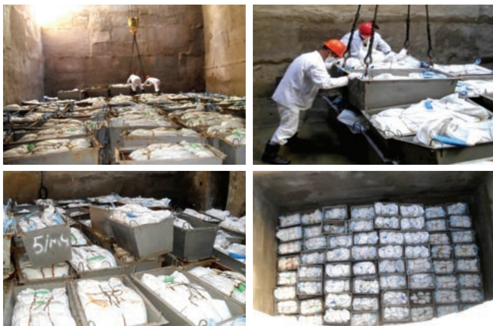
Рисунок 3.26. Размещение ТУКов в хранилище
