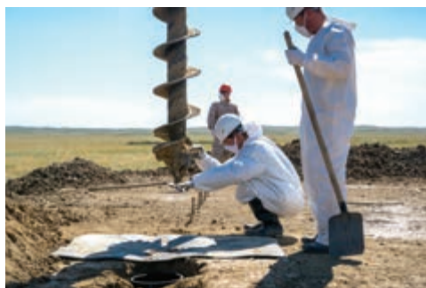
в) Буровые работы на площадке
