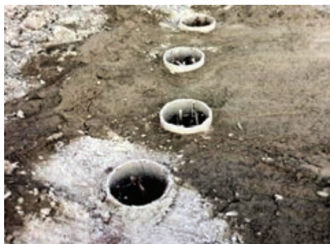
е) Скважины, подготовленные к заливке бетоном
