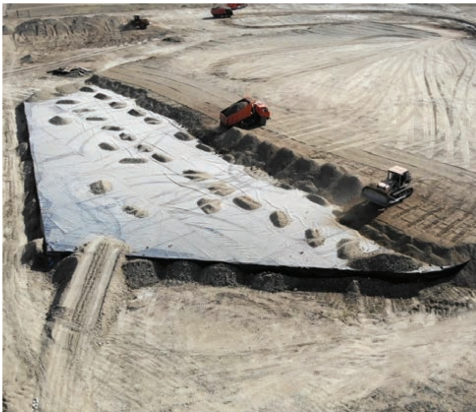
б) Обваловка грунтом
