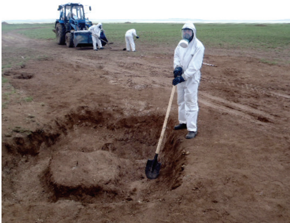
Рисунок 3.3. Корректирование глубины изъятия по результатам оперативного контроля
