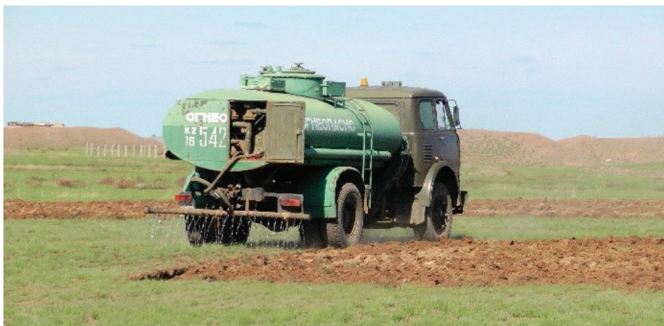
Рисунок 3.4. Орошение участка под вспашку и рабочей площадки
