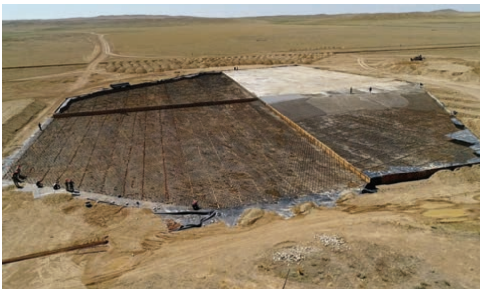
д) Процесс бетонирования больших участков по секторам - участок «Посейдон»
