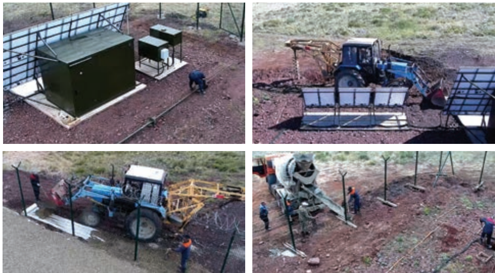
Рисунок 4.8. Работы по монтажу инженерных сооружений
