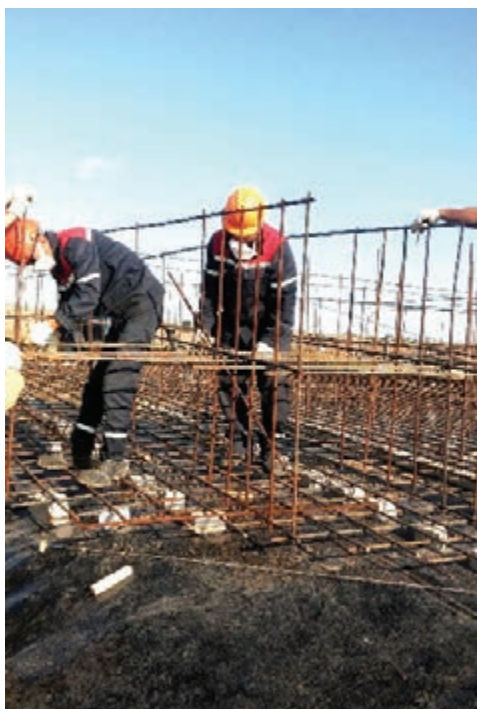
Рисунок 3.31. Этапы армирования защитного колпака
