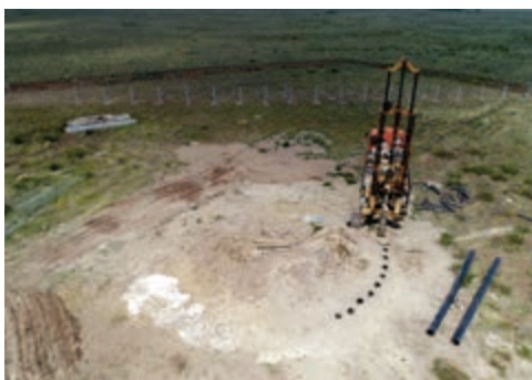
г) Процесс бурения и обсадки скважин
