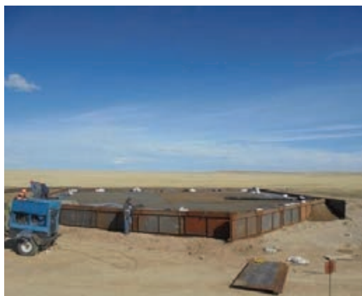
к) Площадка «Гестия» перед бетонированием
