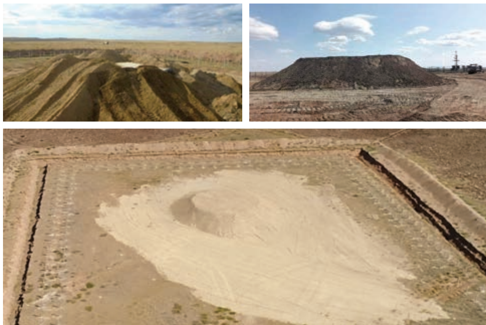
Рисунок 3.35. Обваловка защитного сооружения
