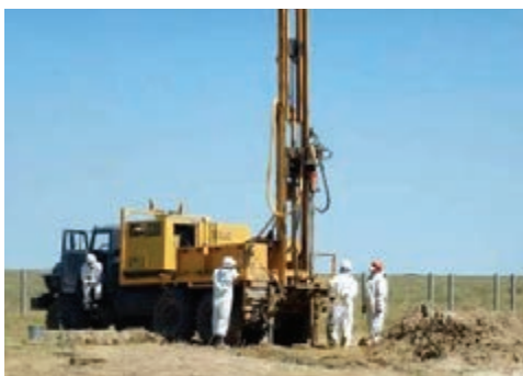
д) Чистка скважин компрессором
