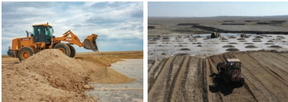
а) Обваловка грунтом
