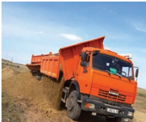
а) Разгрузка чистого грунта для отсыпки загрязненных участков
