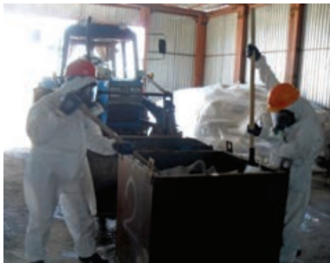
б) Извлечение грунта с ОЯД из контейнера (ТУК)
