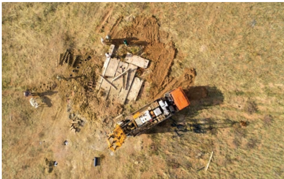
а) общий вид объекта «Пандора» на этапе бурения
