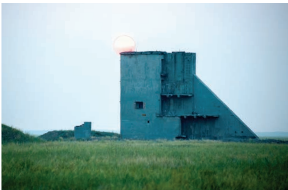
Рисунок 1.5. Современное состояние приборного сооружения «букашка»
