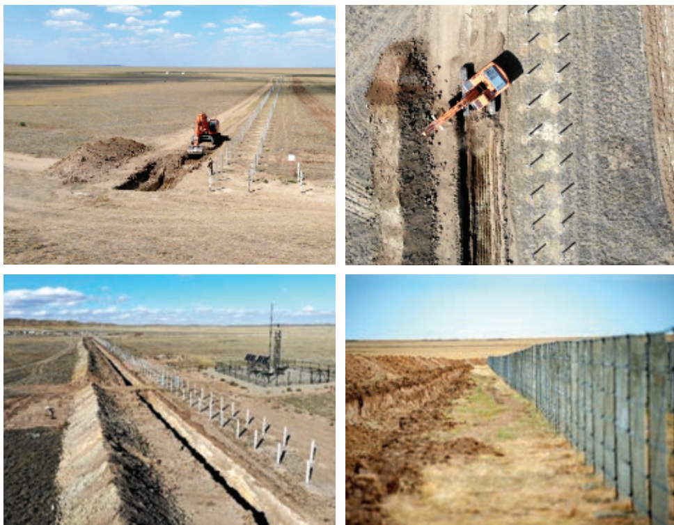
Рисунок 4.6. Создание рва и насыпи вокруг наружного периметра
