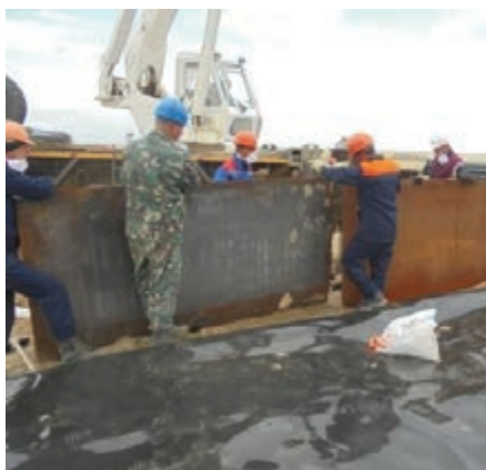
и) Монтаж опалубки
