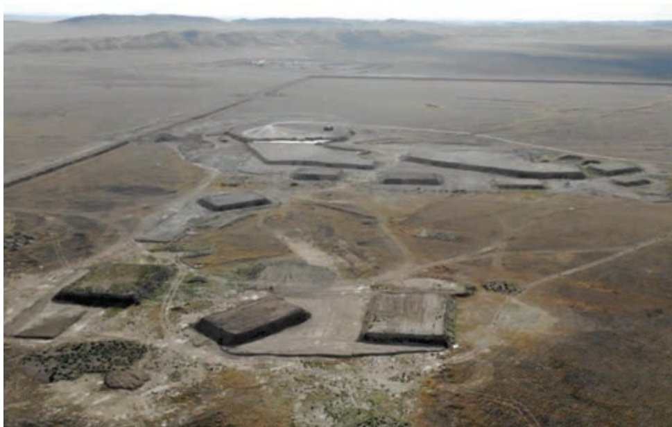
Рисунок 3.57. Вид на объект «Олимп» по окончании работ
