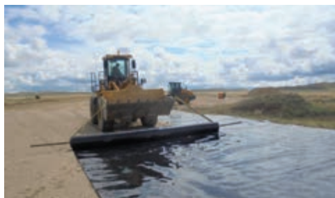
а) Укладка гидроизоляционного слоя
