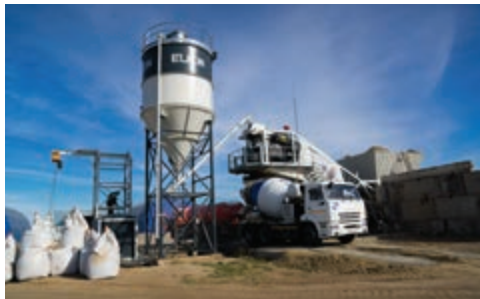
а) Заправка АБС бетонной смесью
