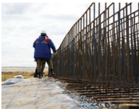
д) Монтаж вертикальных стоек и верхнего ряда
