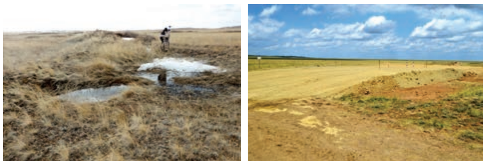
Рисунок 2.21. Объект Т-5 до и после подготовки площадки для бурения скважин
