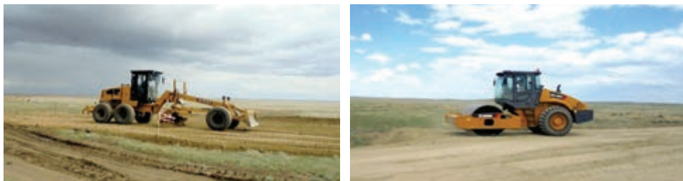
Рисунок 3.42. Планировка территории: отсыпка, грейдирование и уплотнение грунта
