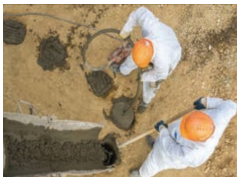
е) Уплотнение залитого бетона вибратором
