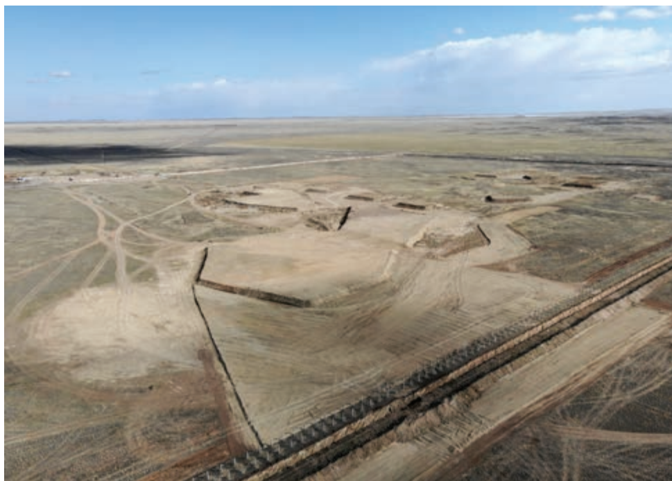
в) Вид на обвалованные сооружения
