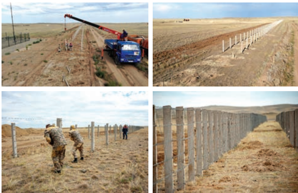
Рисунок 4.4. Монтаж колючей проволоки
