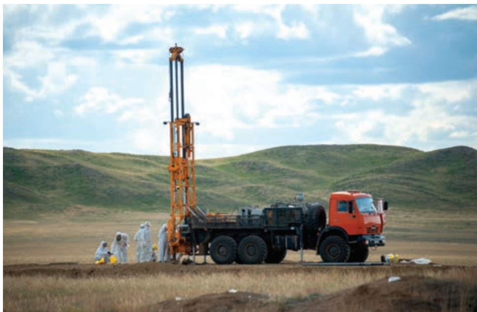
Рисунок 2.22. Бурение скважин на площадке П-2М
