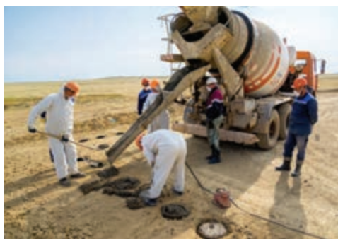
г) Бетонирование скважин
