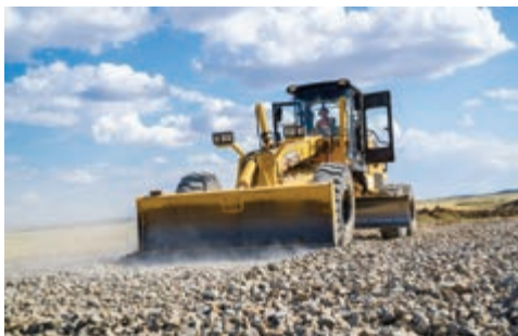
б) Разравнивание щебня
