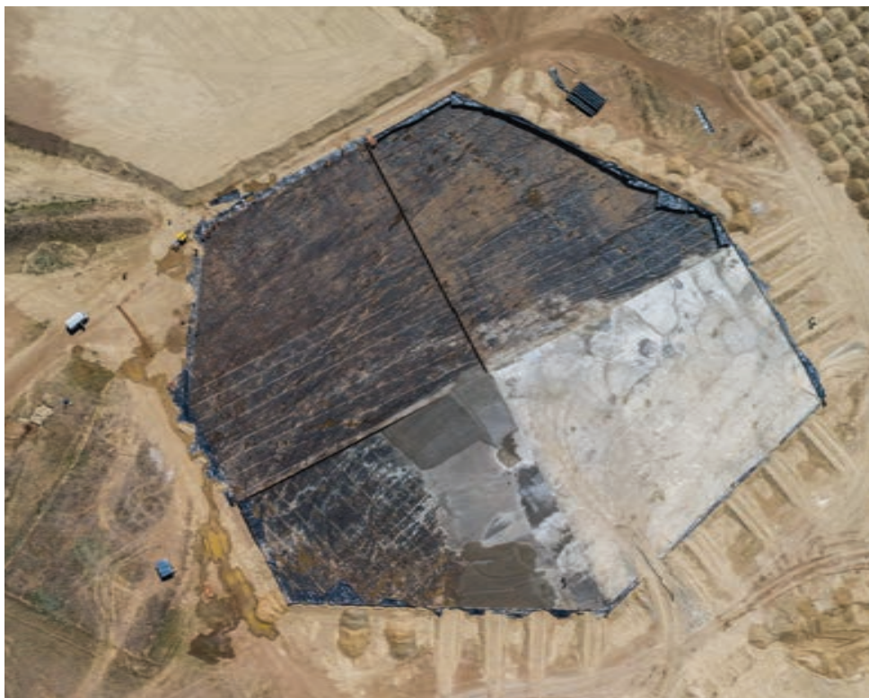
е) Процесс бетонирования больших участков по секторам - участок «Посейдон»
