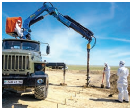
б) Бурение крано-манипуляторной установкой
