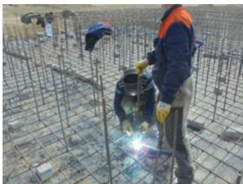
г) Монтаж вертикальных стоек
