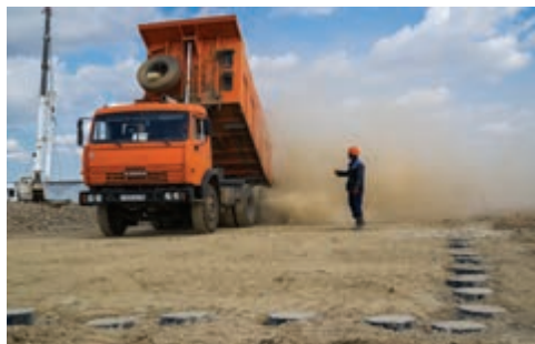
а) Завоз щебня на площадку
