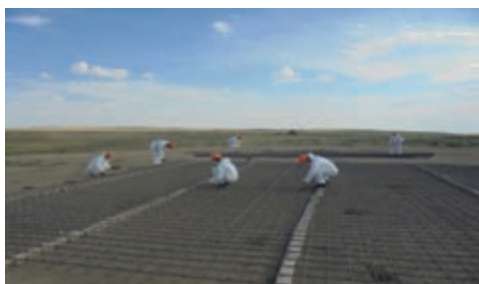
а) Изготовление сеток из арматуры
