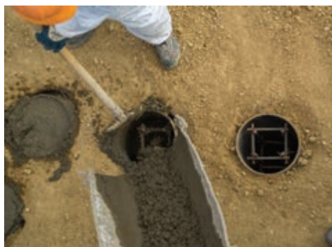
д) Бетонирование скважин
