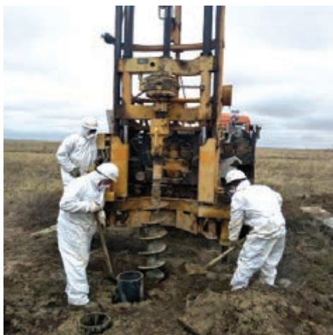
в) Буровые работы с применением стандартных шнеков
