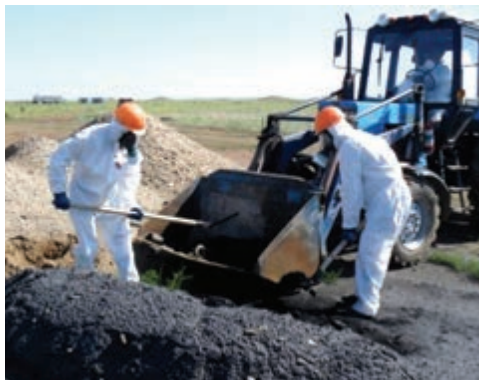
а) Подготовка сухой грунто-бетонной смеси
