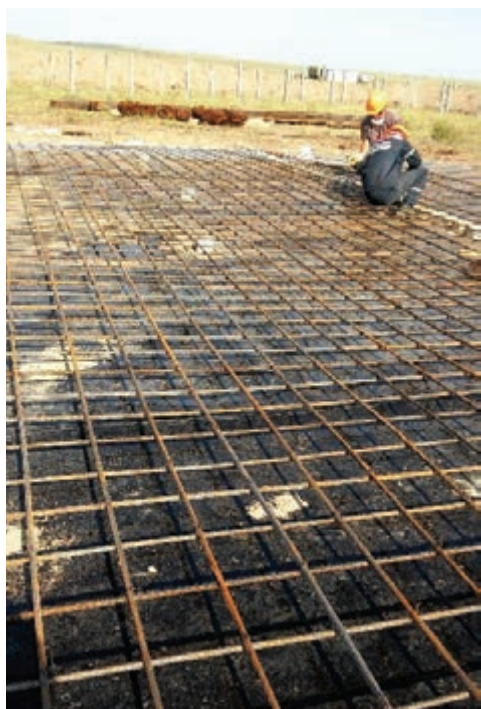
Рисунок 3.31. Этапы армирования защитного колпака
