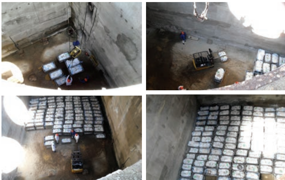
Рисунок 3.9. Размещение контейнеров в хранилище
