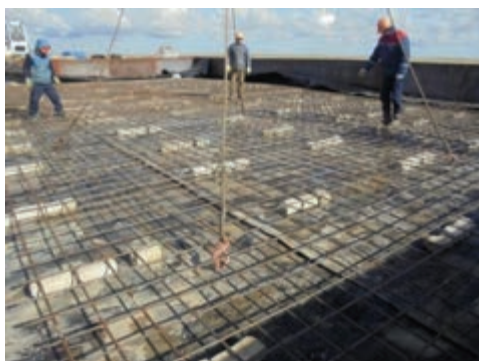
в) Монтаж нижнего ряда арматурного каркаса защитного колпака
