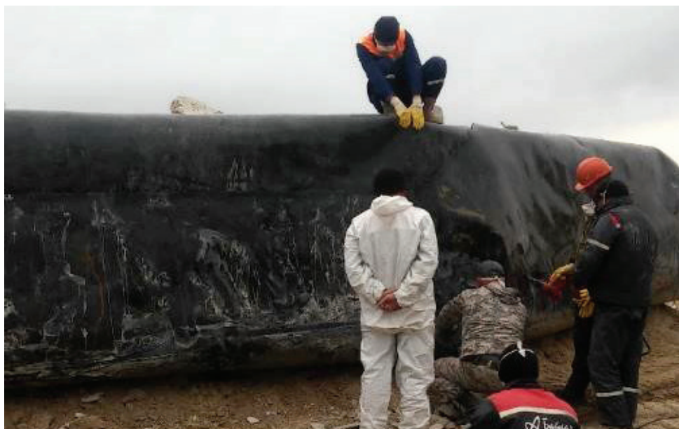
Рисунок 3.34. Гидроизоляция железобетонного колпака
