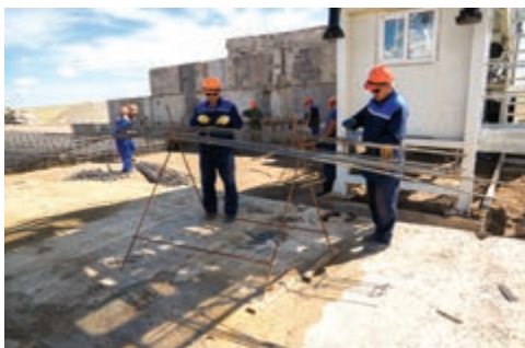
б) Изготовление каркасов
