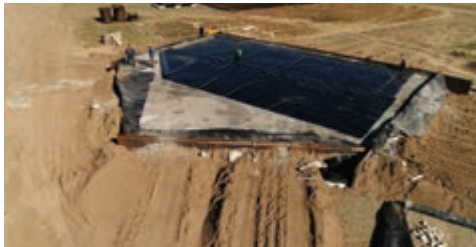
г) Гидроизоляция верхней части защитного колпака
