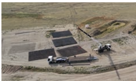
б) Складирование сеток на рабочей площадке
