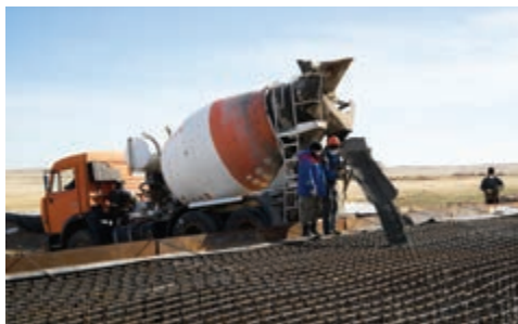
б) Заливка бетона на площадке «Афина»
