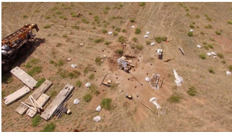
Рисунок 2.47. Участок буровых работ, 2017 г.
