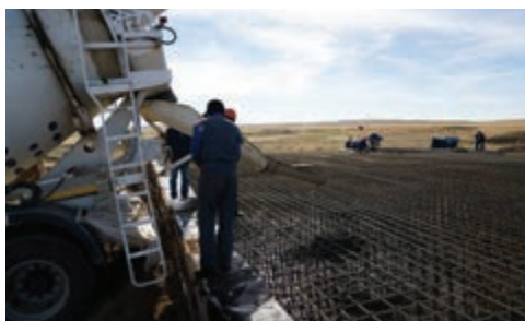
в) Заливка бетона на площадке «Афина»
