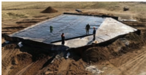
в) Гидроизоляция верхней части защитного колпака
