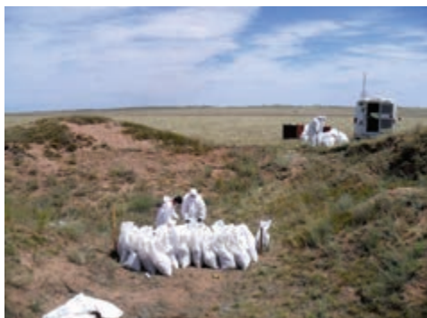
в) Контроль качества изъятия спектрометром и изъятый грунт
