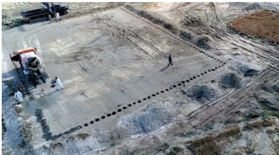
ж) Вид на частично забетонированные скважины на площадке «Деметра»
