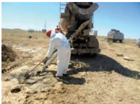
ж) Бетонирование скважин
