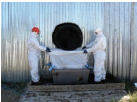
г) Прием готового грунтобетона в ТУКи
