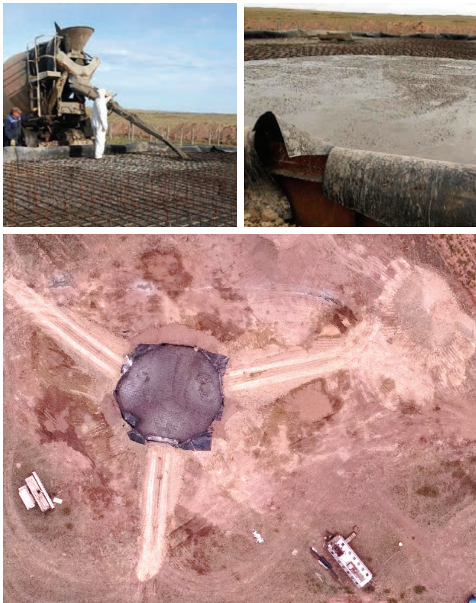
Рисунок 3.33. Этапы заливки бетоном
