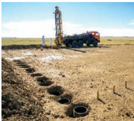
а) Бурение скважин буровой установкой
