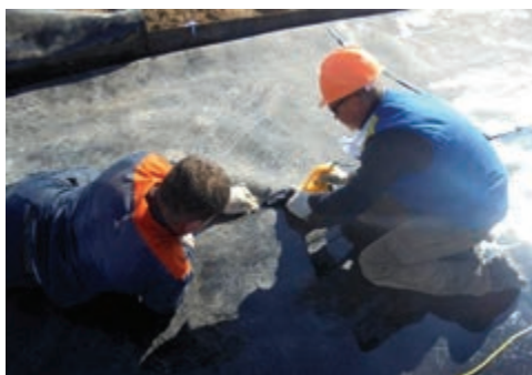
в) Сварка геомембраны
