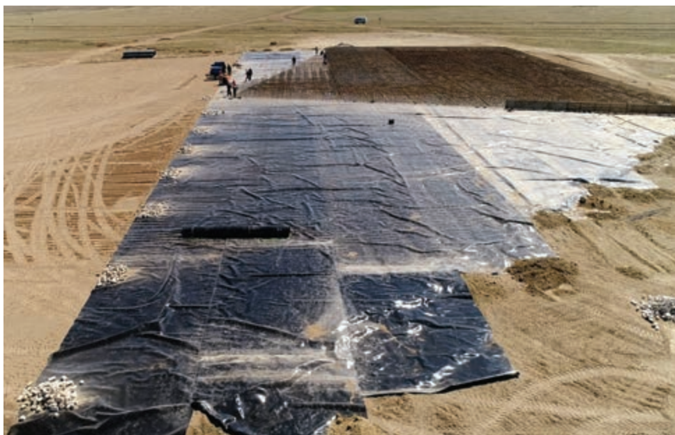
з) Укладка геомембраны и установки каркаса на площадке с секционной заливкой
