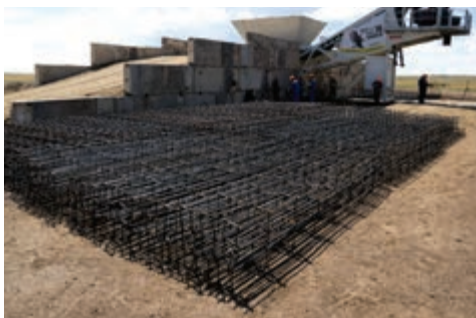
г) Склад готовых каркасов для скважин
