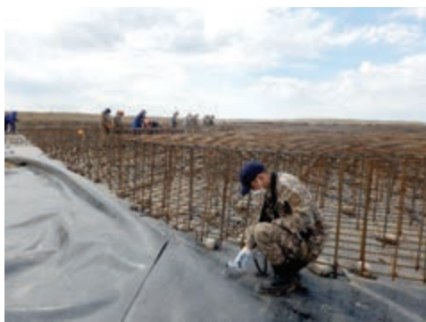
а) Радиационный контроль на месте проведения работ
