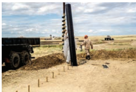
г) Установка обсадной трубы в скважину
