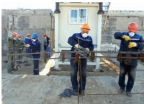
б) Изготовление каркасов
