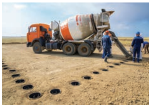
в) Бетонирование скважин
