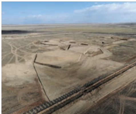
б) Отсыпка загрязненных участков
