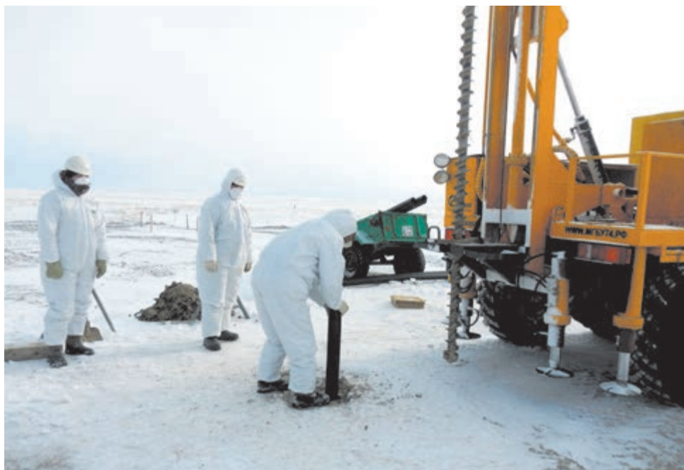
Рисунок 2.25. Обсаживание скважины
