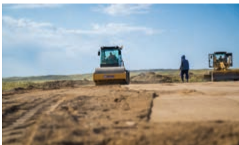
г) Уплотнение песчаного основания вibroкаткомоснования
