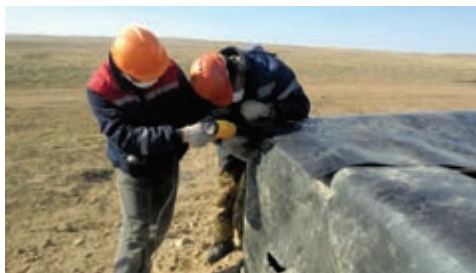
б) Сварка верхнего и нижнего слоя геомембраны
