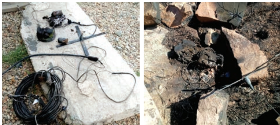
Рисунок 4.19. Поврежденное пожаром оборудование
