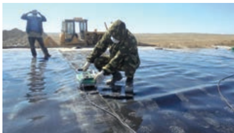
а) Сварка верхнего слоя геомембраны
