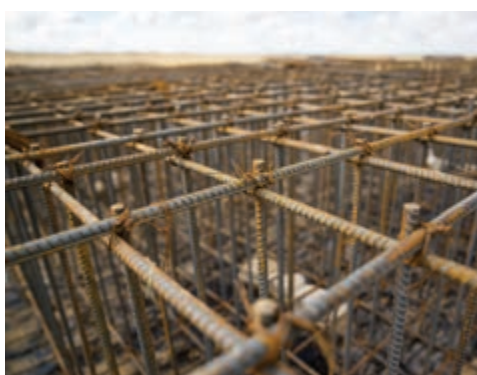
е) Монтаж верхнего ряда
