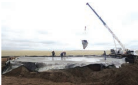
г) Подача бетона автокраном с дозатором. Площадка «Гестия»
