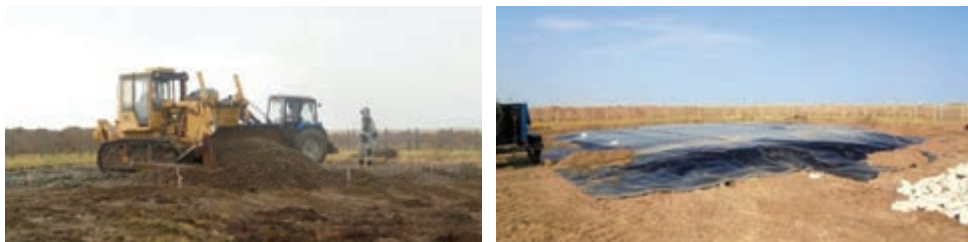
а) Планировка щебня и укладка геомембраны
