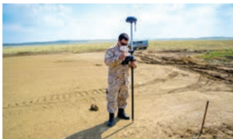
а) вынос точек для бурения скважин с использованием высокоточного GPS
