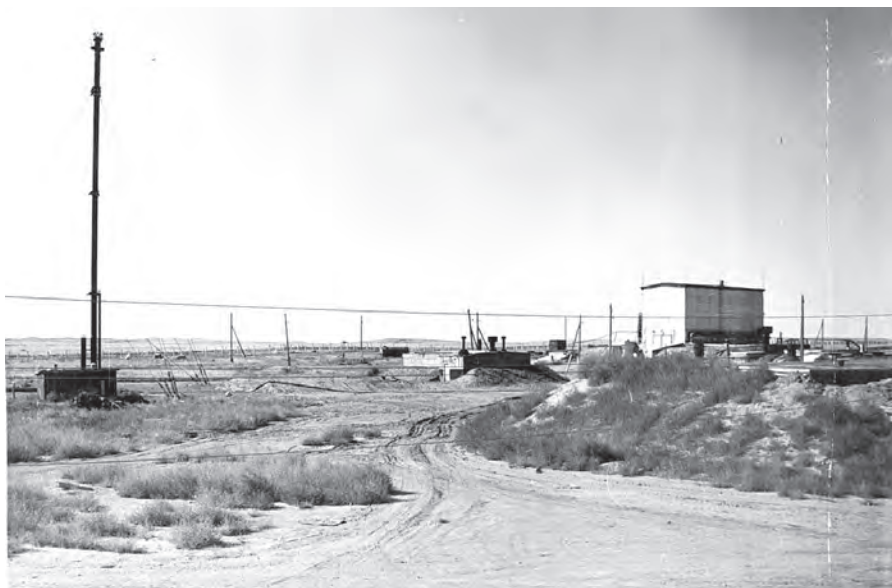
Рисунок 4 - 1967 год. Здание реактора с пристройками технологических систем
