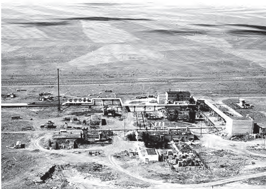
Рисунок 5 - 1985 год. Практически законченный строительством КИР ИГР
