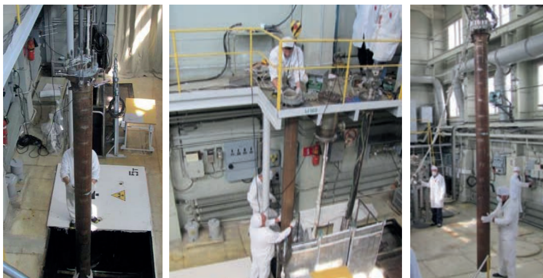
д) процесс сборки корпусов ЭУ
