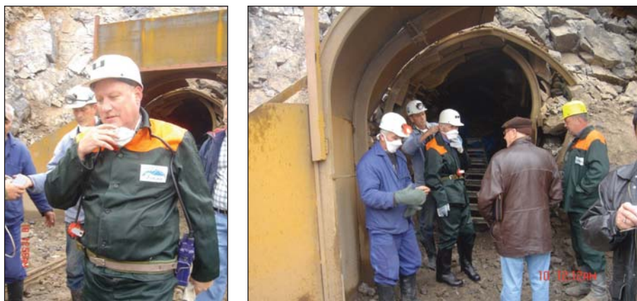
Рисунок 3.105. Обследование сооружения на объекте «Х»
