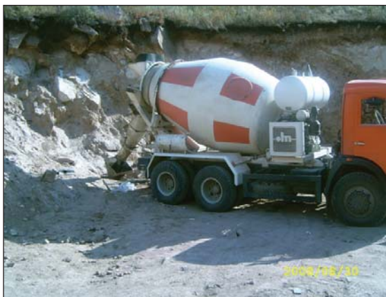
Подготовка раствора на БРУ и заливка магнетитом бокса
