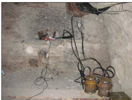
Рисунок 3.202. Вскрытие защитного контейнера
