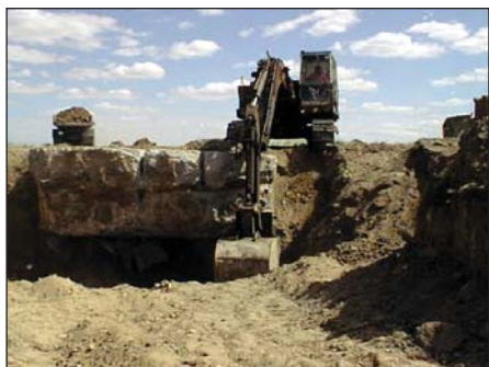
Рисунок 3.45. Ликвидация бетонной пробки на скважине №1
