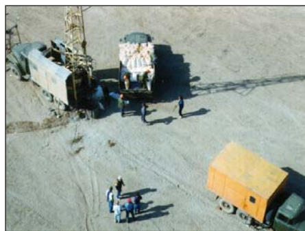
Рисунок 2.25. Скважина №1349. Закладка ВВ
