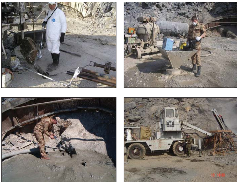
Рисунок 3.101. Радиационный контроль при производстве работ
