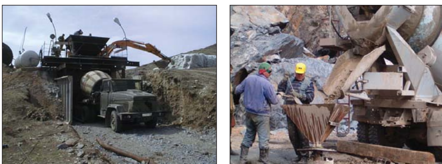
Рисунок 3.86. Заливка камеры и бокса бетонным раствором
