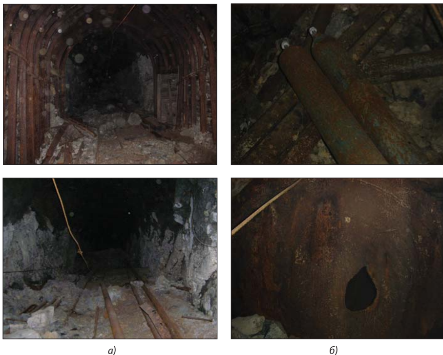
Рисунок 3.96. Состояние сооружения (а) и следы несанкционированной деятельности (б)
