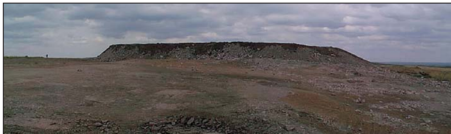
Рисунок 3.36. Вид на сооружение с юга
