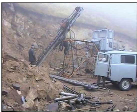
Рисунок 3.206. Вертикальное бурение в полость штольни
