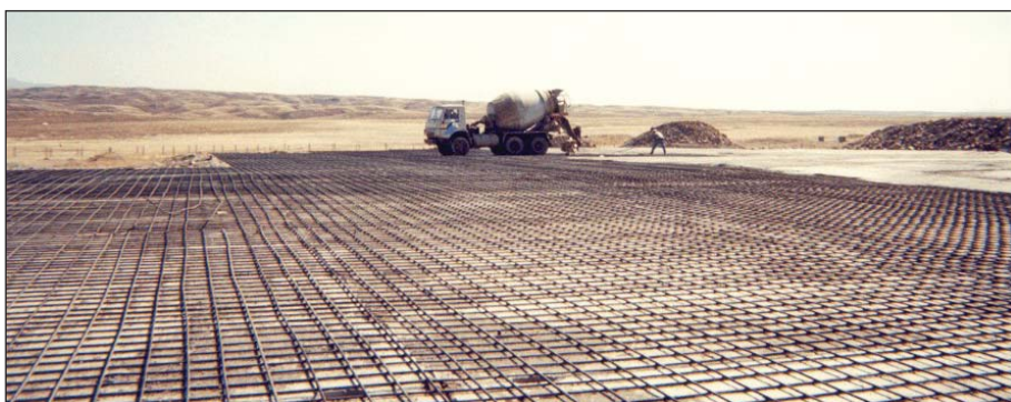
Рисунок 3.26. Арматурная сетка и укладка бетона в цементную стяжку
