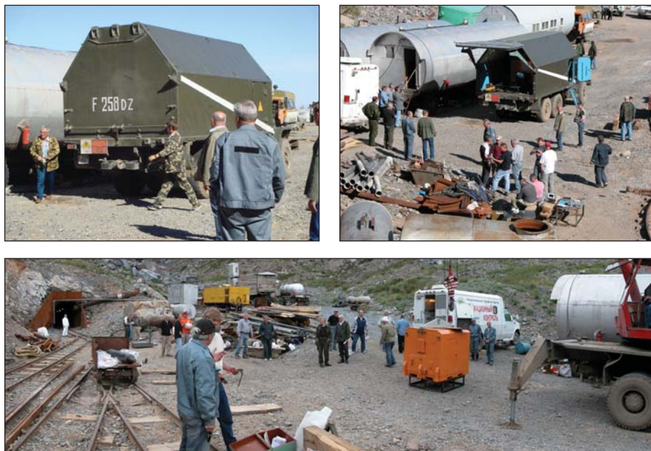
Рисунок 3.154. Транспортный контейнер на рабочей площадке
