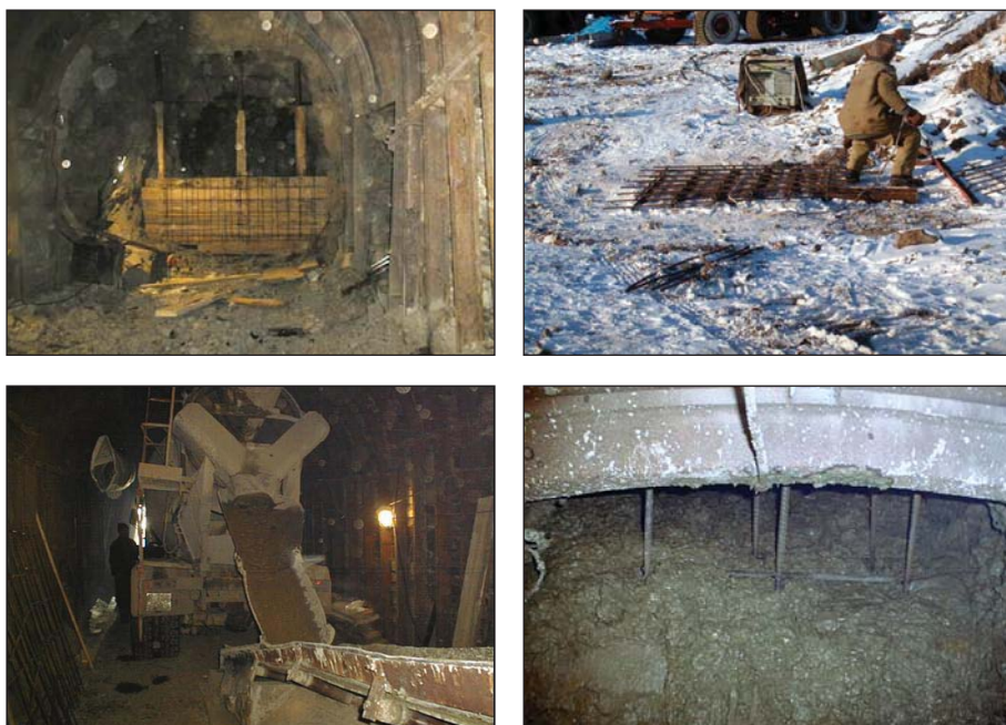
Рисунок 3.99. Устройство бетонной пробки
