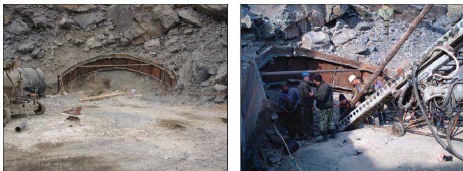
Рисунок 3.84. Обсадка скважин трубами
