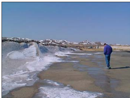
Рисунок 3.28. Осмотр состояния цементной стяжки
