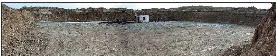
Рисунок 3.47. Выравнивание поверхности котлована
