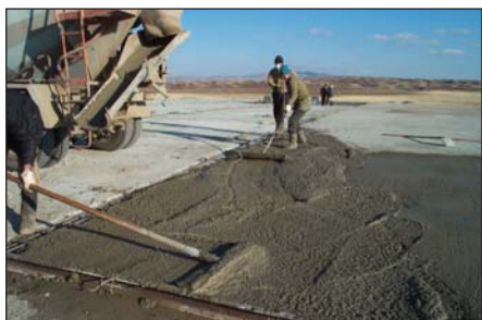
Рисунок 3.29. Укладка бетона
