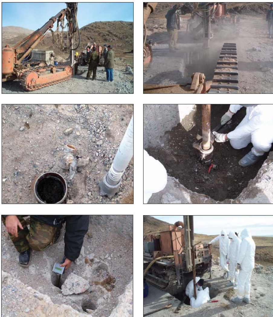
Рисунок 3.74. Заполнение контейнера раствором и дозиметрический контроль
