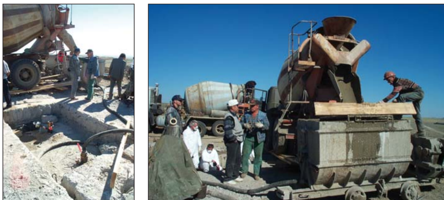
Рисунок 3.70. Заполнение бетоном «Колбы»
