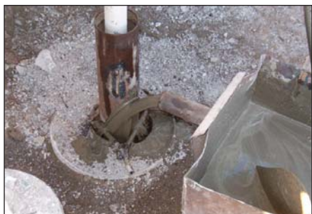
Рисунок 3.90. Цементация затрубного пространства скважины
