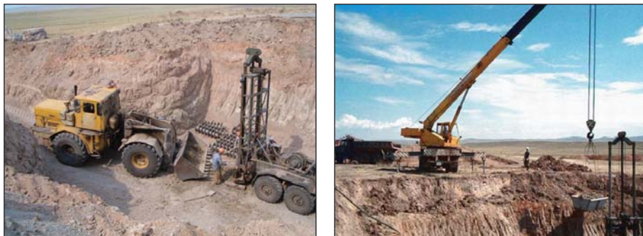
Рисунок 3.51. Удаление грунта из котлована
