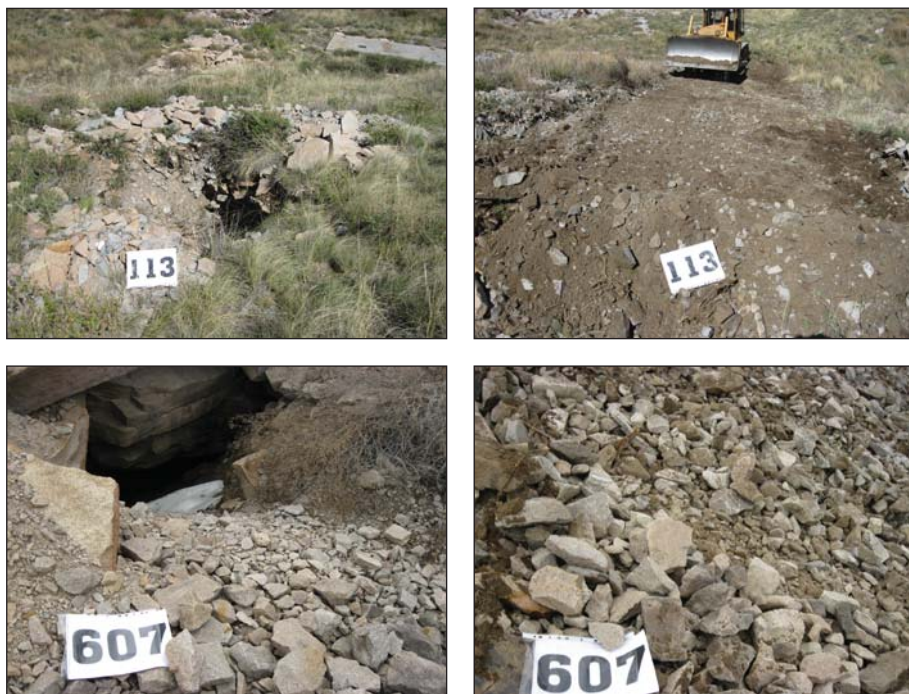
Рисунок 3.213. Пример усиления защиты на некоторых инженерных сооружениях
