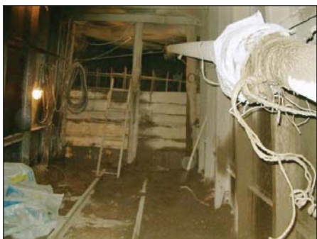
Рисунок 3.143. Устройство бетонной защитной пробки на отметках 38–48 метров
