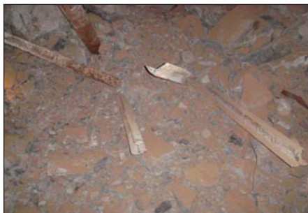
Рисунок 3.109. Обрушенная порода, конструкции и металлический лом, подлежащие уборке и вывозу
