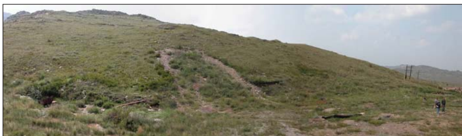
Рисунок 3.125. Площадка на объекте «У» до начала работ
