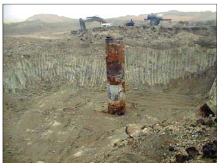
Рисунок 3.46. Удаление обсадных труб
