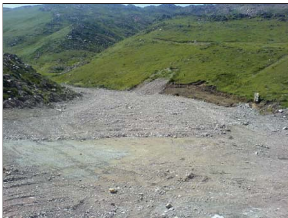
Рисунок 3.150. Общий вид площадки объекта «У» после окончания работ
