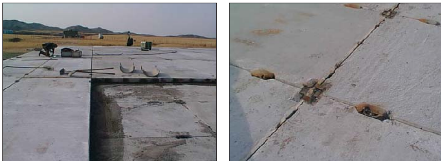
Рисунок 3.21. Соединение плит в ряду
