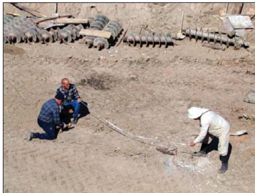
Рисунок 3.49. Разбивка местоположения специальных скважин
