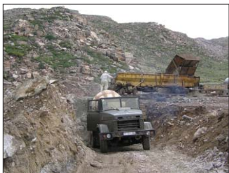
Рисунок 3.142. Бетонирование бокса
