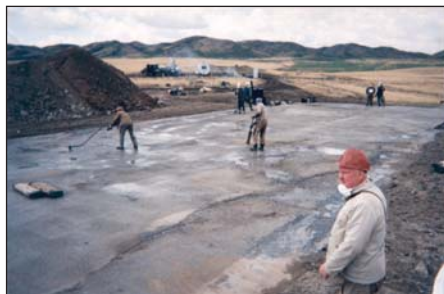
Рисунок 3.30. Подготовка участка к укладке рубероида
