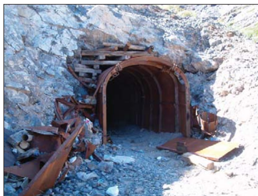
Рисунок 3.118. Работы на сооружении
