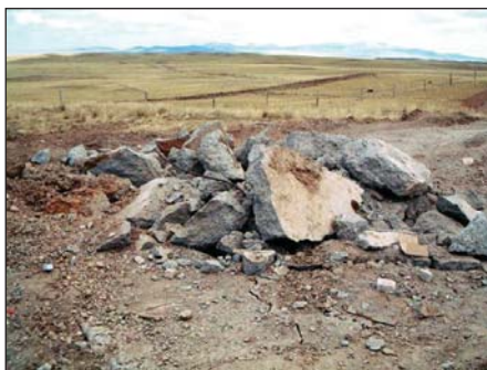
Рисунок 3.45. Ликвидация бетонной пробки на скважине №1
