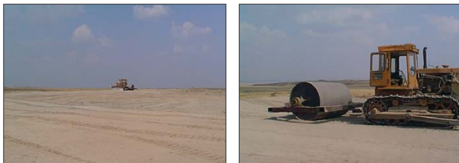
Рисунок 3.16. Планировка и уплотнение основания
