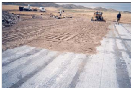
Рисунок 3.32. Защитный слой из песка
