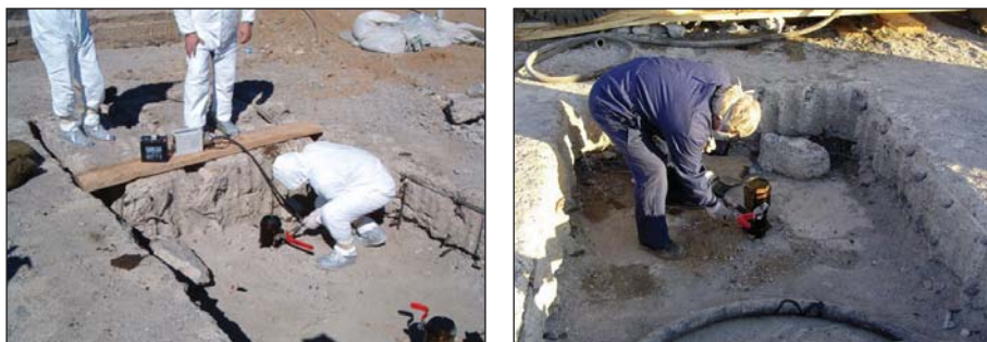
Рисунок 3.71. Контроль состояния газовой среды и замена фильтрующего элемента
