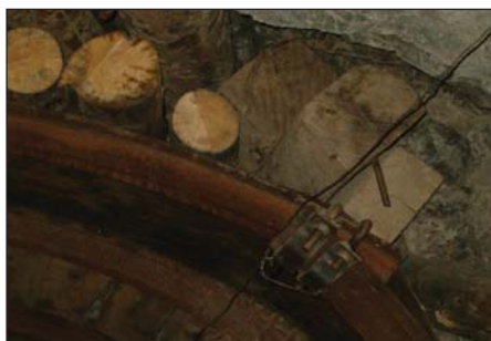
Рисунок 3.110. Крепление выработки
