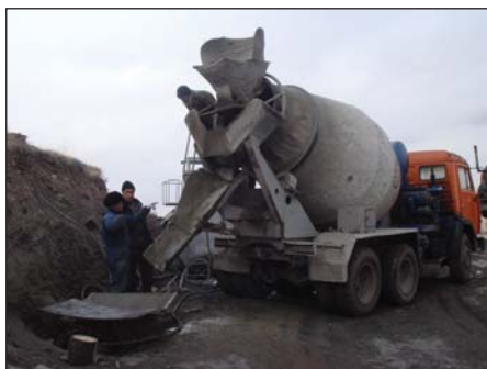
Рисунок 3.176. Заливка боксов растворами
