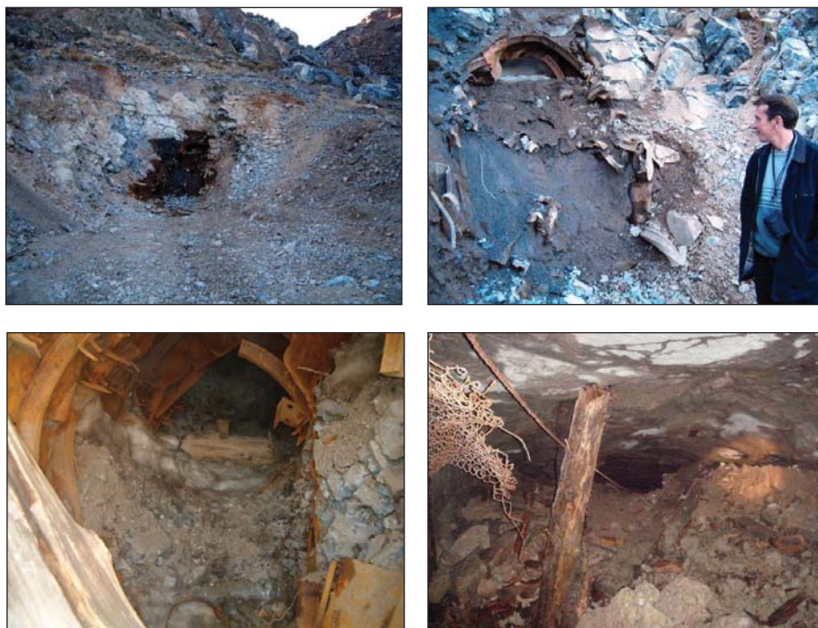
Рисунок 3.104. Вид на портал сооружения
