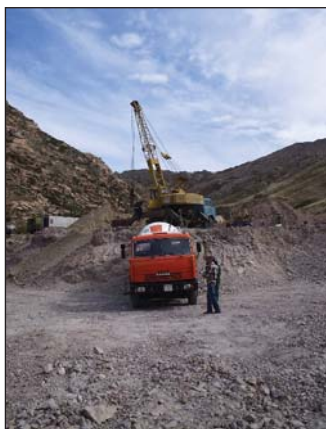
Подготовка раствора на БРУ и заливка магнетитом бокса
