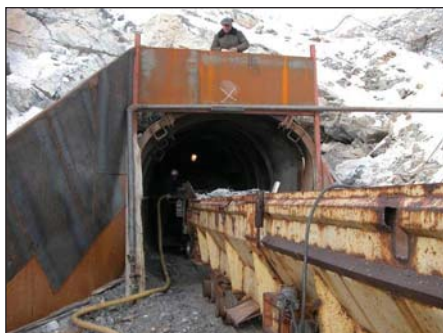
Вывоз породы из сооружения
