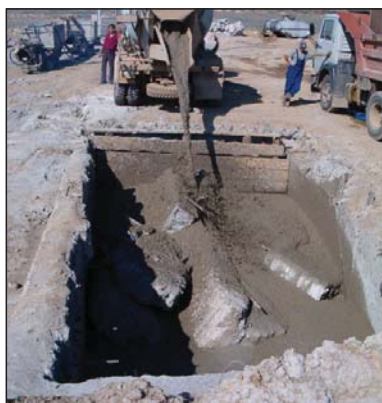
Рисунок 3.65. Заполнение контейнера раствором (а) и восстановление бетонного перекрытия (б)
