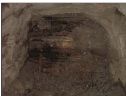
Рисунок 3.201. Демонтаж защитных элементов
