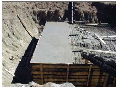
Рисунок 3.59. Укладка бетона по участкам и его выравнивание
