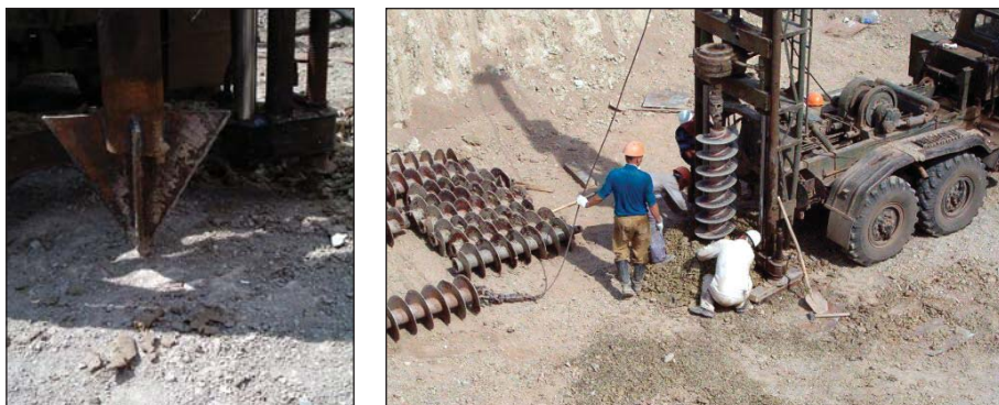
Рисунок 3.50. Бурение специальных скважин
