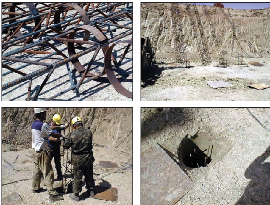
Рисунок 3.52. Изготовление и установка арматурной сетки
