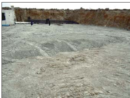
Рисунок 3.55. Создание щебеночной подушки
