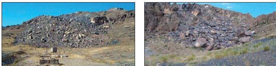
Рисунок 3.76. Вид сооружений на объекте «Кочевник»
