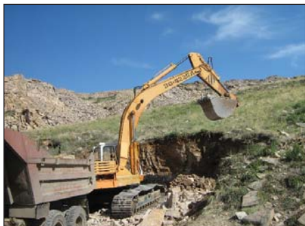
Рисунок 3.200. Вскрытие и сооружение врезной траншеи, монтаж порталных рам
