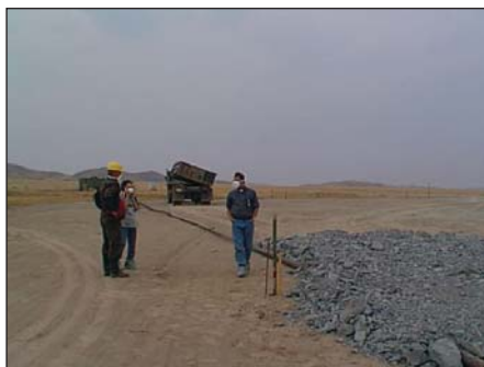
Рисунок 3.17. Укладка щебня в дренажную систему
