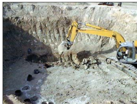
Рисунок 3.54. Захоронение обсадных труб в котловане
