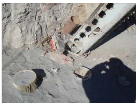
Бурение наклонных скважин
