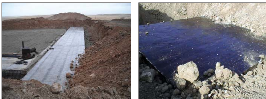
Рисунок 3.61. Подготовка котлованов к засыпке
