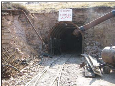
Рисунок 3.200. Вскрытие и сооружение врезной траншеи, монтаж порталных рам
