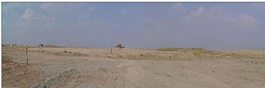
Рисунок 3.15. Вид на участок работ с засыпанными загрязненными зонами
