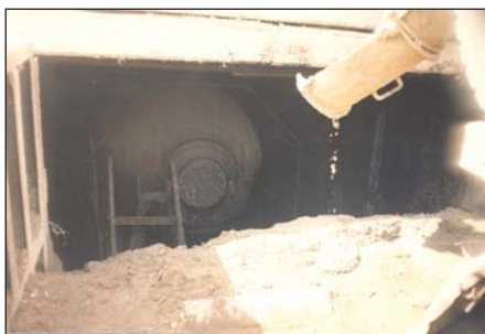
Рисунок 3.4. Заливка бетоном всего сооружения, в котором располагается контейнер «Колба»
