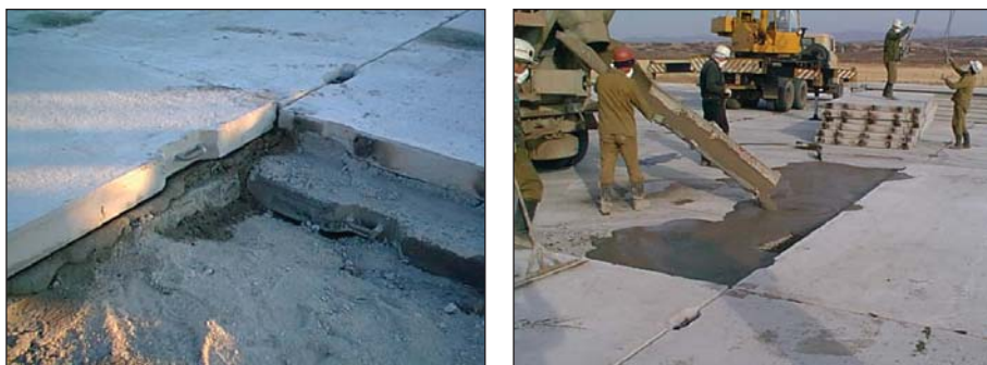
Рисунок 3.22. Укладка мелкозернистого бетона между рядами плит
