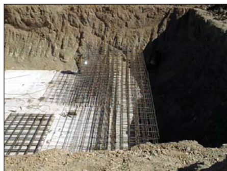
Рисунок 3.57. Изготовление арматурной сетки
