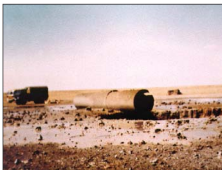
Рисунок 2.24. Скважина №1381 после взрыва
