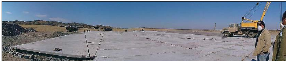
Рисунок 3.23. Вид на 2-й ряд плит
