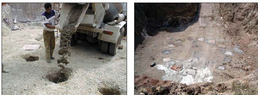
Рисунок 3.53. Заливка скважин бетоном
