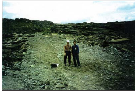
Рисунок 2.4. Штольня № 192 (после засыпки портала)
