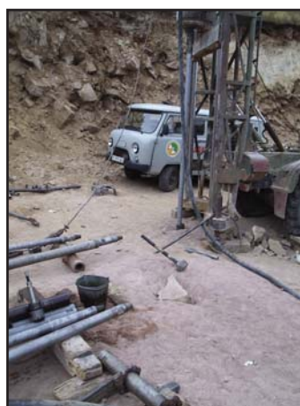
Рисунок 3.206. Вертикальное бурение в полость штольни
