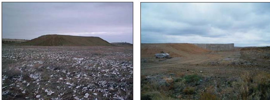
Рисунок 3.75. Вид на сооружение после проведения работ
