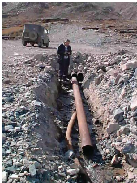
Рисунок 2.10. Сооружение фильтра у портала штольни №176
