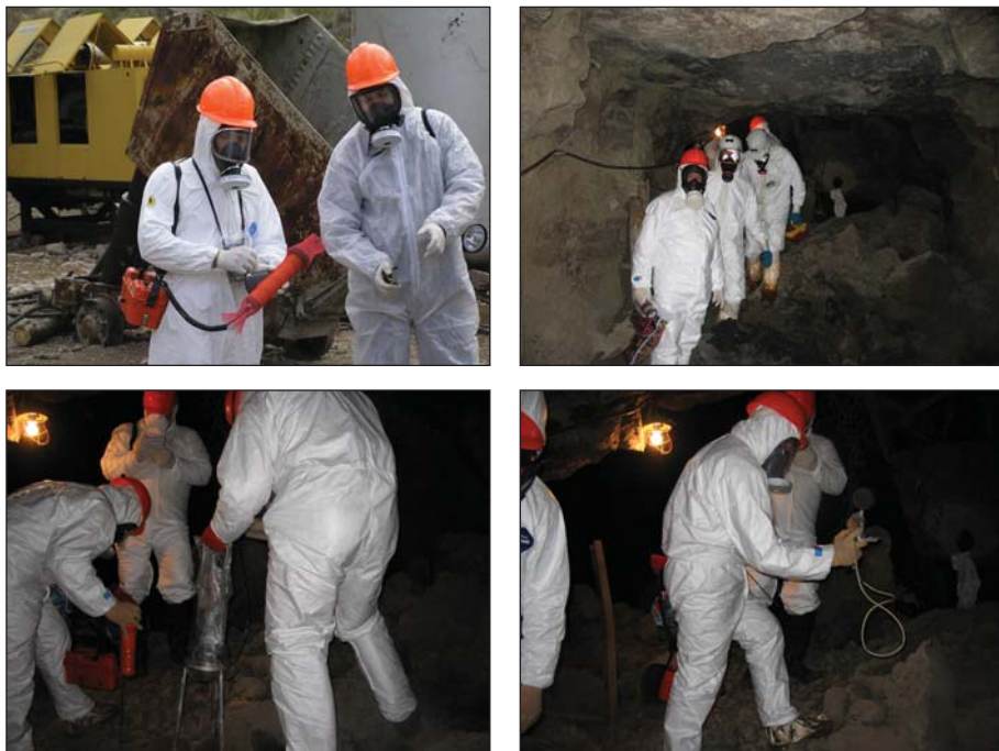
Рисунок 3.141. Обследование бокса сооружения
