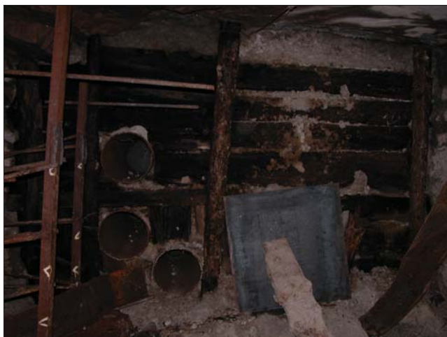
Рисунок 3.136. Гермоэлемент с гермолазом на пикете 140 метров
