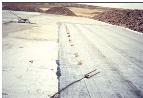
Рисунок 3.31. Укладка рубероида
