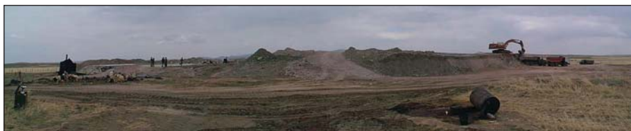
Рисунок 3.33. Общий вид работ по возведению насыпи
