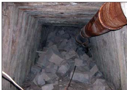
Завал сооружения при его закрытии
