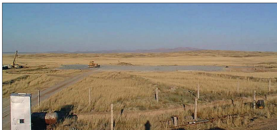
Рисунок 3.18. Общий вид площадки
