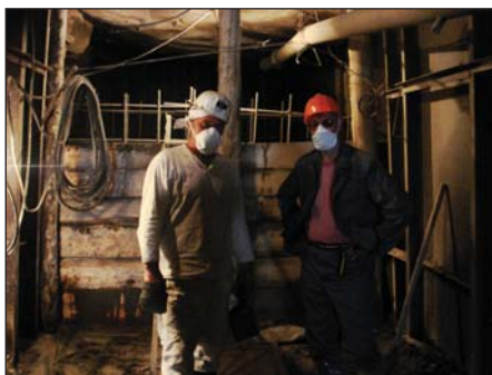
Рисунок 3.143. Устройство бетонной защитной пробки на отметках 38–48 метров
