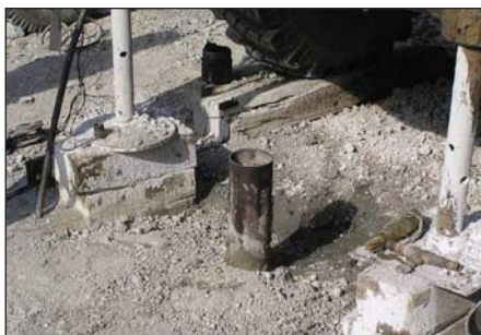
Рисунок 3.90. Цементация затрубного пространства скважины
