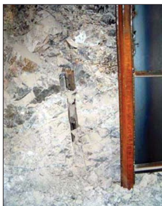
Рисунок 3.112. Тектоническая трещина на правом борту сооружения и гермолаз
