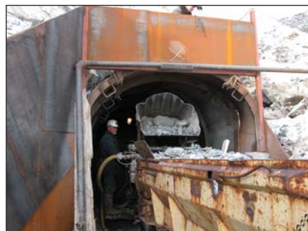
Вывоз породы из сооружения
