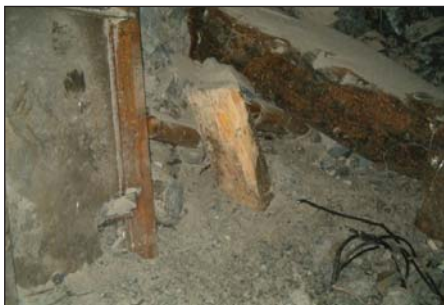
Рисунок 3.109. Обрушенная порода, конструкции и металлический лом, подлежащие уборке и вывозу
