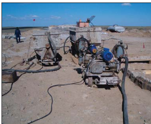
Рисунок 3.65. Заполнение контейнера раствором (а) и восстановление бетонного перекрытия (б)
