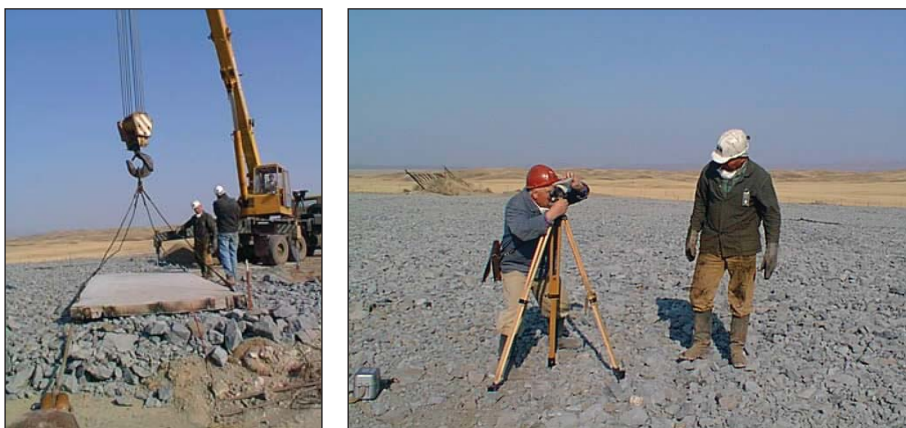
Рисунок 3.20. Укладка первого ряда плит
