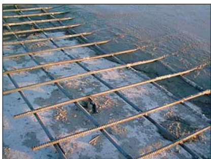
Рисунок 3.27. Укладка арматурной сетки
