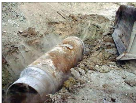
Рисунок 3.54. Захоронение обсадных труб в котловане
