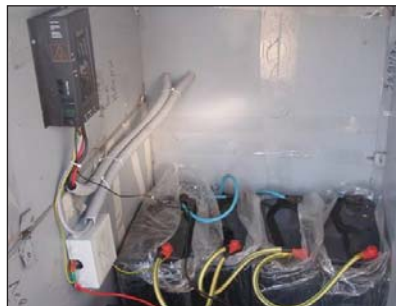
Рисунок 3.244. АКБ и контроллер солнечного заряда
