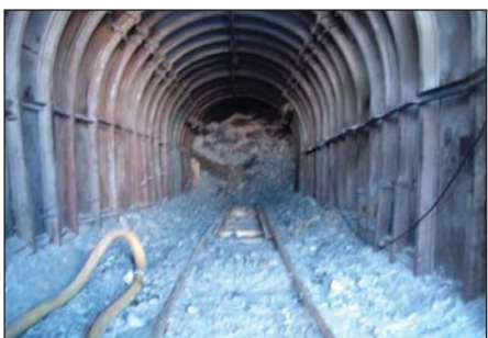
Рисунок 3.109. Обрушенная порода, конструкции и металлический лом, подлежащие уборке и вывозу
