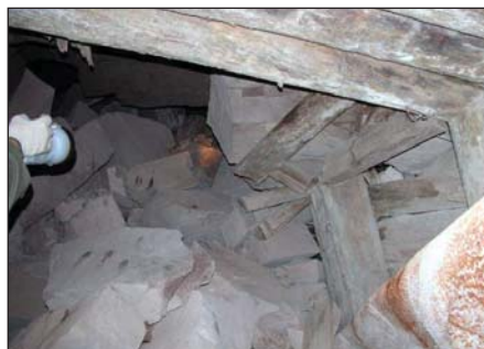
Завал сооружения при его закрытии
