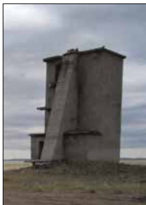
Рисунок 1.11. Слева – мощное 4-этажное железобетонное приборное сооружение с ребром жесткости – «гусак». Расположено на технической площадке «П-1». Справа – бронеколпак долговременной огневой точки (ДОТ)
