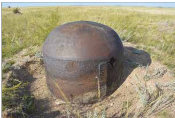
Рисунок 1.11. Слева – мощное 4-этажное железобетонное приборное сооружение с ребром жесткости – «гусак». Расположено на технической площадке «П-1». Справа – бронеколпак долговременной огневой точки (ДОТ)
