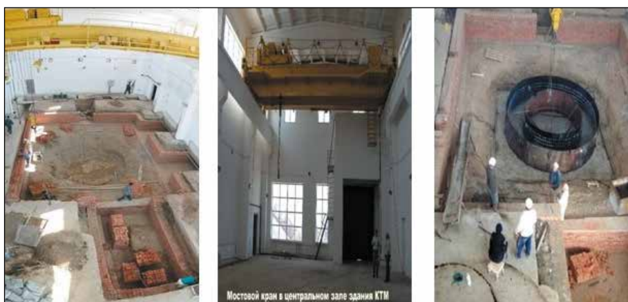
Рисунок 1.40. Начало работ в реакторном зале КТМ
