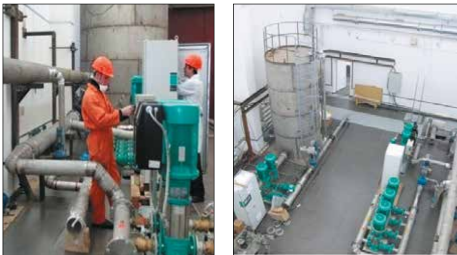
Рисунок 1.36. Система водяного охлаждения
