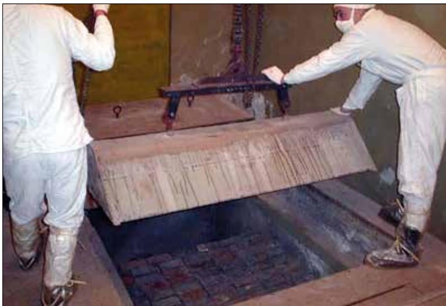
Рисунок 2.8. Хранилище уран-графитовых блоков со снятой железобетонной крышкой
