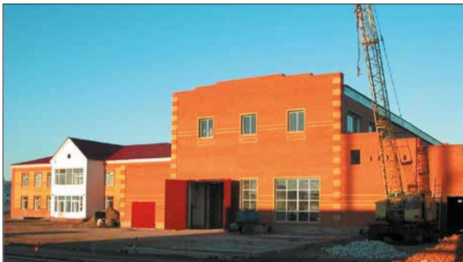
Рисунок 1.44. Лабораторный корпус и здание КТМ
