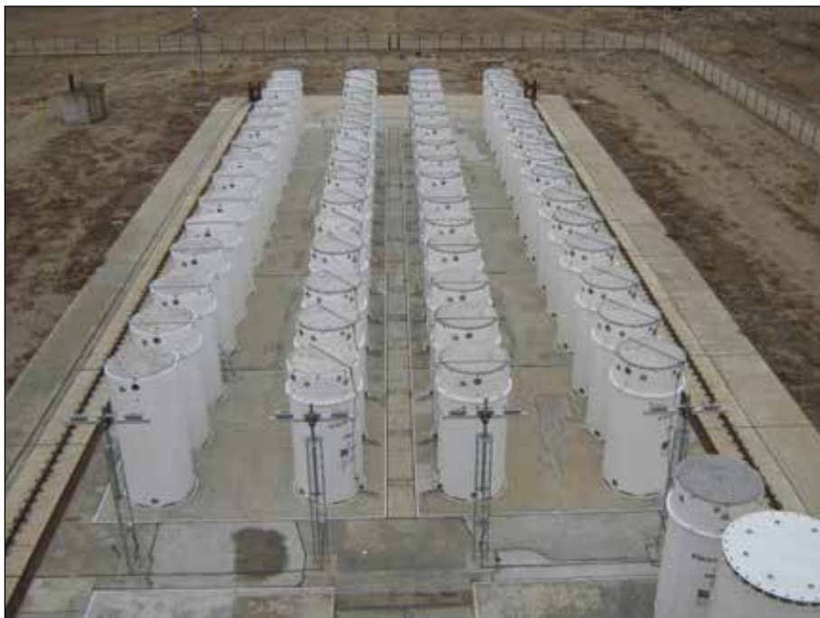
Рисунок 3.31. Вид площадки для долговременного хранения ОЯТ
