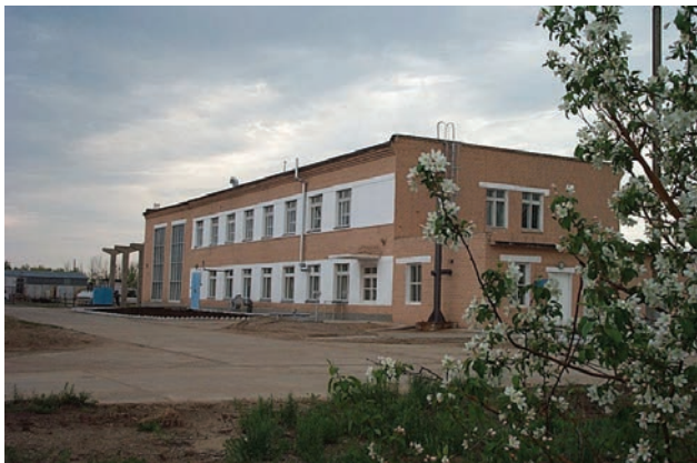
Здание 225А после завершения строительно-монтажных работ. Апрель 2000 года
